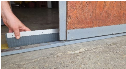
1. ábra Innovatív, rágcsálóknak ellenálló megoldás nyílászárók résmentesítésére
