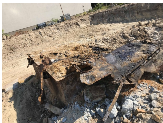
3. ábra föld alatti tartály kibontás után
