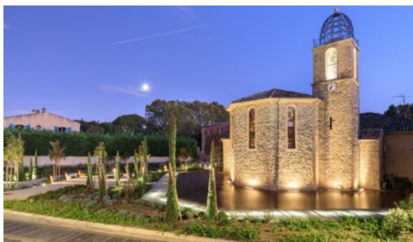
3. ábra Châteauneuf-le-Rouge-i műemlék megvilágítása a parkolóban kiépített wattway rendszerrel történik ( https://www.wattwaybycolas.com/en/the-solar-road.html )
