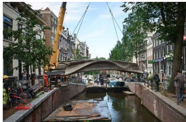
2.ábra Az első acélmentes +D nyomtatott híd Amszterdamban (Adriaan De Groot felvétele)
