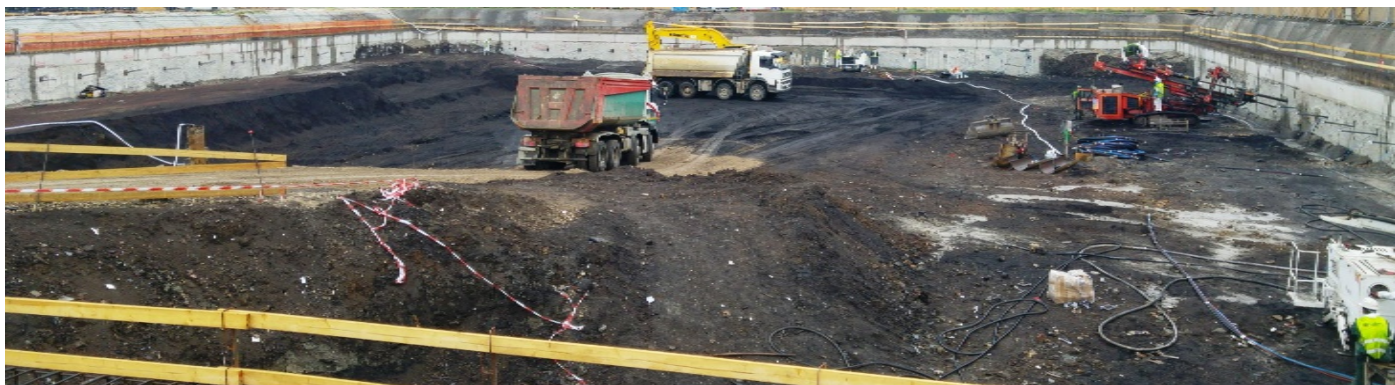
1. ábra mélyépítési munkák egy építkezés helyszínén
